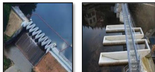
شکل ۱. نمونه‌ای از سرریز کنگره‌ای و سرریز کلیدپیانویی
