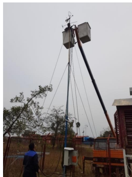
شکل ۱۶. مراحل اجرایی نصب سنسور و تابلوی برق روی دکل.
